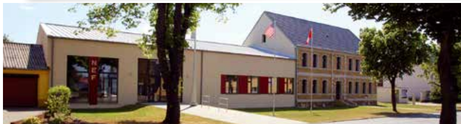
Im energieautarken Ortsteil Feldheim steht das Neue-Energien-Forum.
