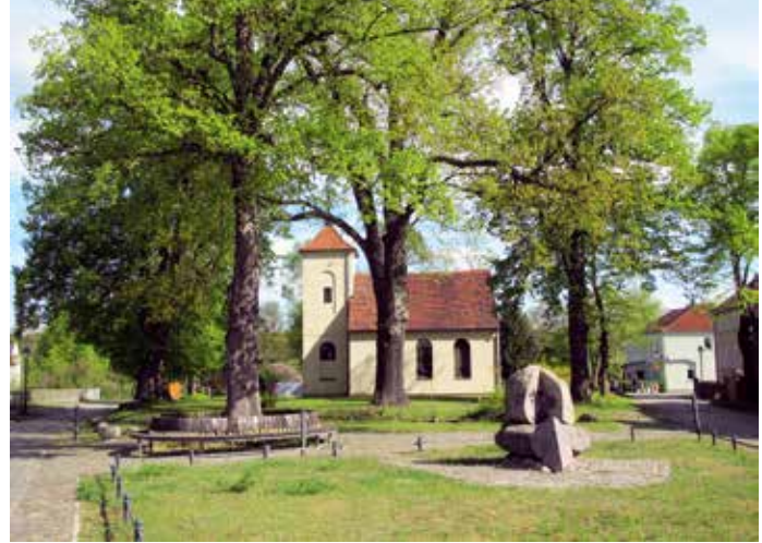
Die evangelische Kirche, erbaut 1735, mit Findlingsdenkmal mitten im Dorf
