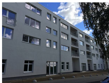
Werder (Havel), Wohnverbund Schubertstraße
