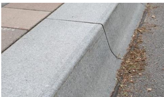
Abbildung 11: Detailansicht eines 18 cm-Bords mit Ausformung zur reifenfreundlichen Anfahrt
