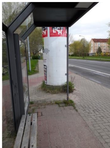
Abbildung 16: Die Sichtbeziehung zwischen Wartenden und dem Fahrzeug ist von besonderer Bedeutung. Daher sind transparente Seitenwände und das Freihalten der Sichtachse zu beachten.
